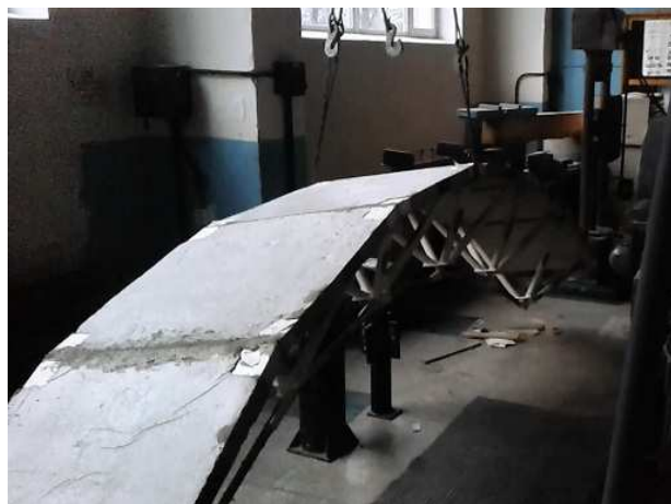
Рис. 8. Просторова структурно-вантова сталезалізобетонна конструкція в процесі монтажу
