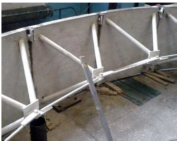
Рис. 6. Збирання просторової структурно-вантової сталезалізобетонної конструкції
