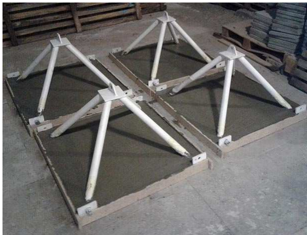
Рис. 5. Бетонування верхнього пояса просторового сталезалізобетонного модуля
