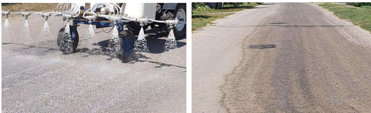
Рис. 3. Розподілення добавки та зовнішній вигляд поверхні асфальтобетонного покриття через 30 хв після обробки покриття омолоджувачем Люкс «ЕД-Л»
