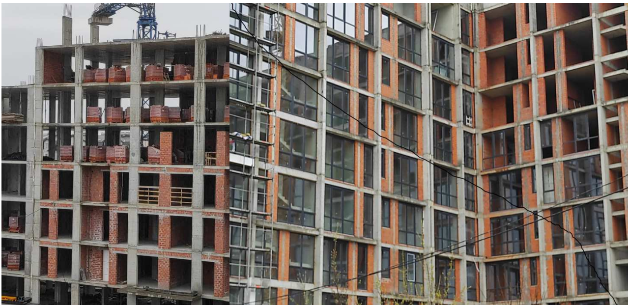
Рис. 2. Каркасні житлові будівлі на стадії зведення
