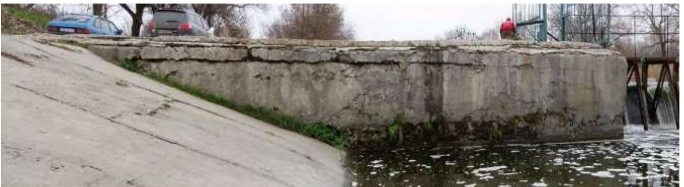
Рис. 4. Правобережный устой Лопанской плотины (вид с нижнего бьефа)
