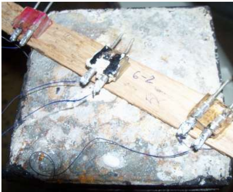
Рис. 19. Образование кальцита на поверхности бетонного образца через некоторое время после начала воздействия образца напряжением
