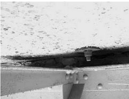
Рис. 3. Выкрашивание и разрушение армированного цементно-песчаного прокладного слоя
