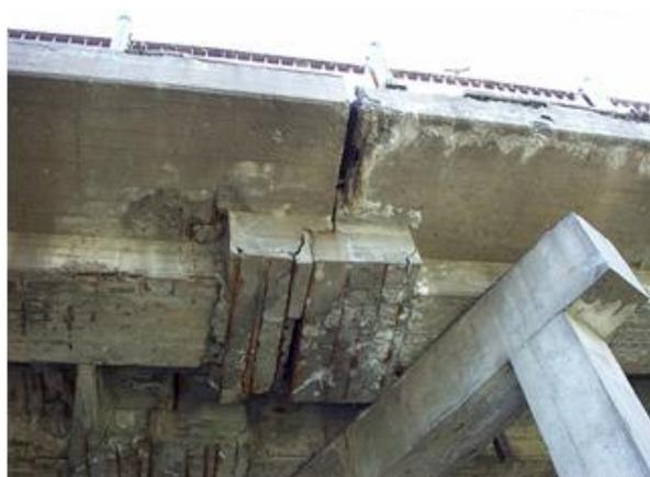
Рис. 5. Фрагменты электрокоррозионного разрушения бетона в железобетонном пролетном строении
