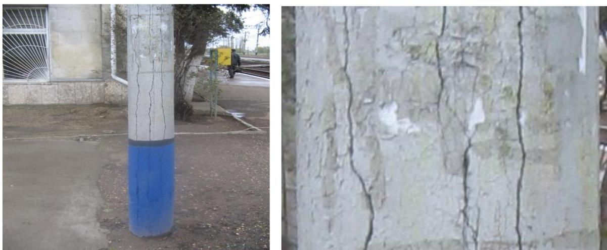
Рис. 3. Продольные трещины в железобетонной центрифугированной опоре освещения возле электрифицированного пути (а) и ее увеличенный фрагмент (б)
