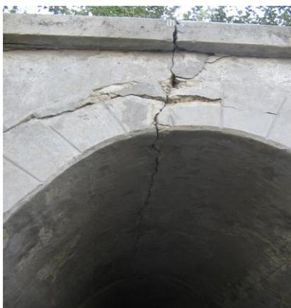
Рис. 4. Трещины в бетоне железобетонного оголовка водопропускной трубы
