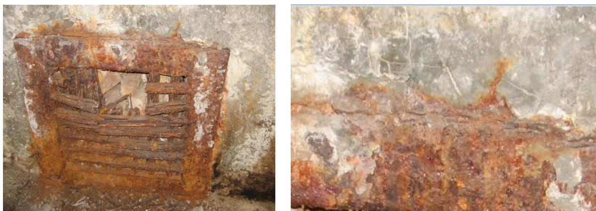
Рис. 2. Электрокоррозионные повреждения вентиляционной решетки и обделки тоннеля Сухарный Приднепровской железной дороги с образованием трещин
