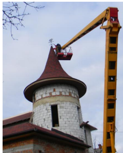
Рис. 6. Блочный монтаж кровли: а – монтаж нижней части кровли; б – монтаж верхней части кровли с флюгером
