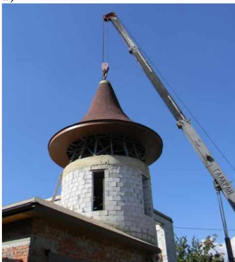
Рис. 6. Блочный монтаж кровли: а – монтаж нижней части кровли; б – монтаж верхней части кровли с флюгером
