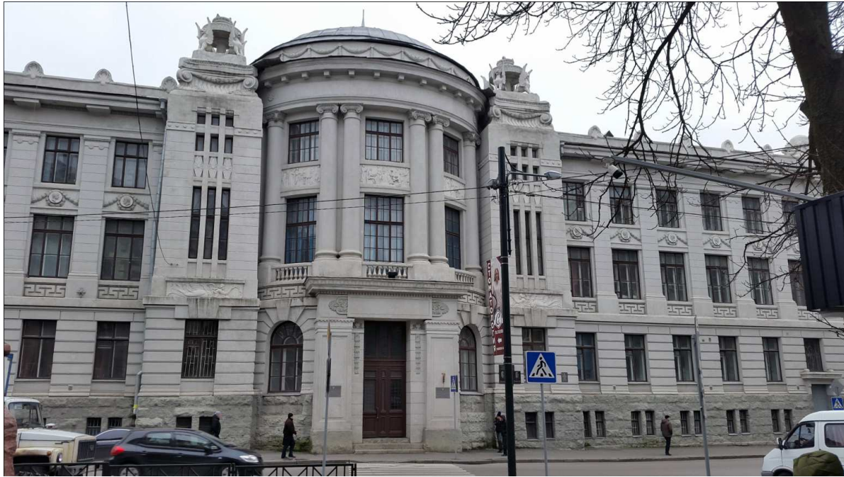
Рис. 4. Здание института им. Мечникова после восстановления фасада
