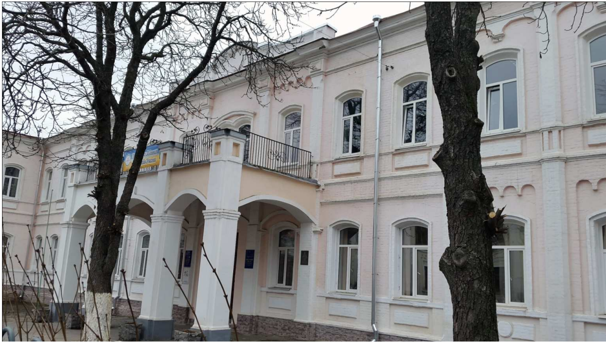
Рис. 3. Фасад здания Мариинской гимназии после ремонта
