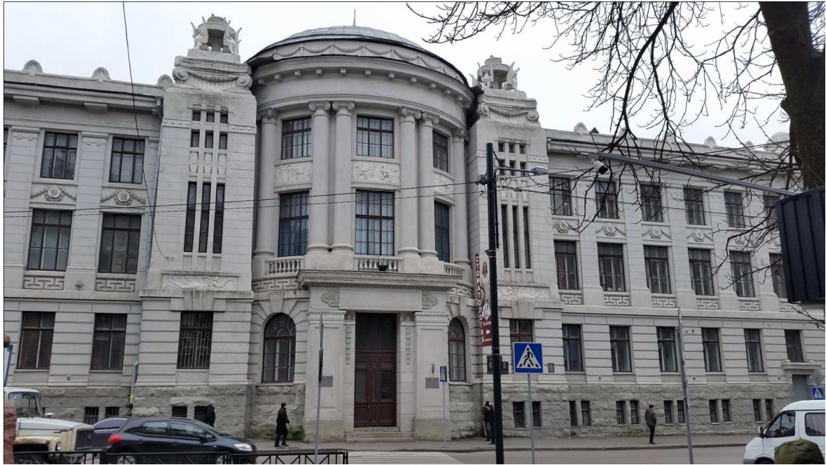
Рис. 4. Здание института им. Мечникова после восстановления фасада
