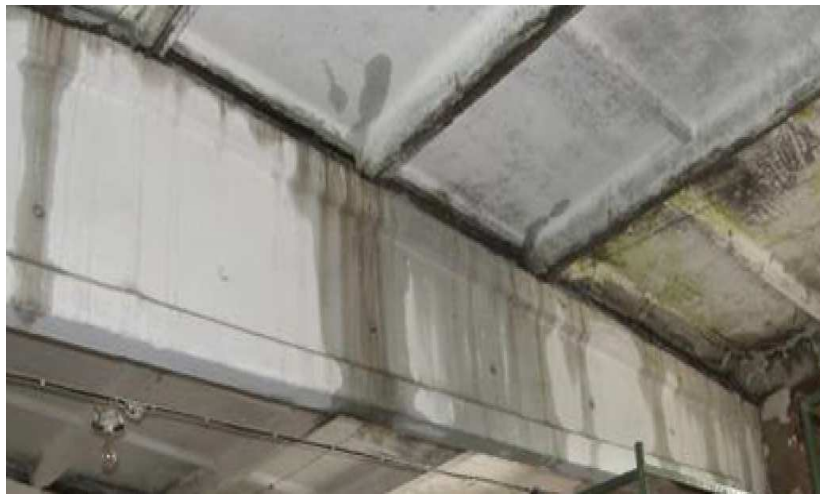
Рис. 1. Замочування двосхилої балки та ребристих плит покриття
