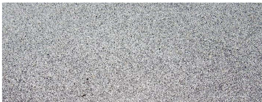
Рис. 1. Нанесені спектли на бетонній призмі
