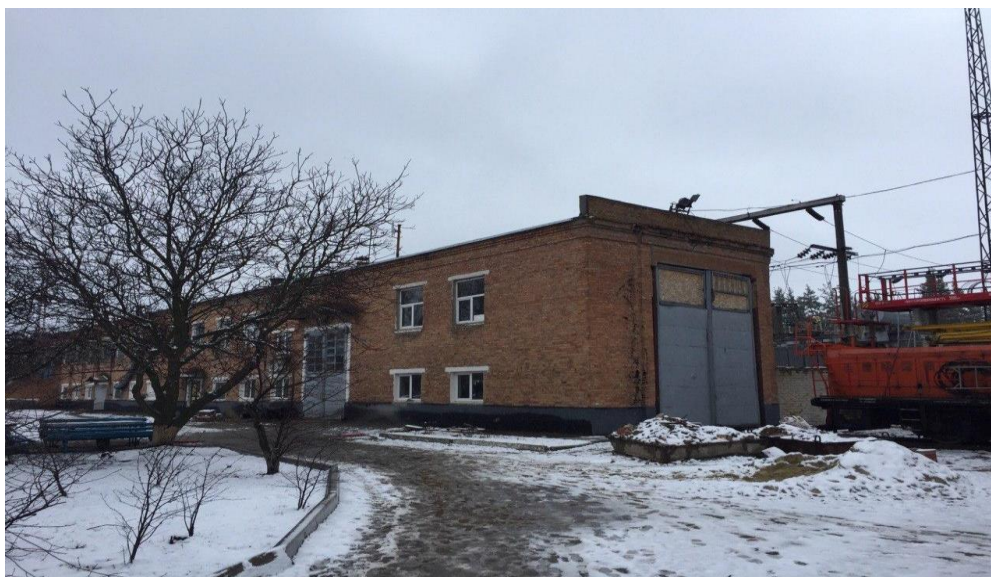
Рис. 1. Загальний вигляд тягової підстанції № 18 м. Зміїв
