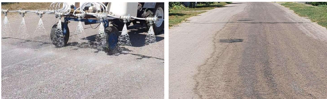
Рис. 3. Розподілення добавки та зовнішній вигляд поверхні асфальтобетонного покриття через 30 хв після обробки покриття омолоджувачем Люкс «ЕД-Л»
