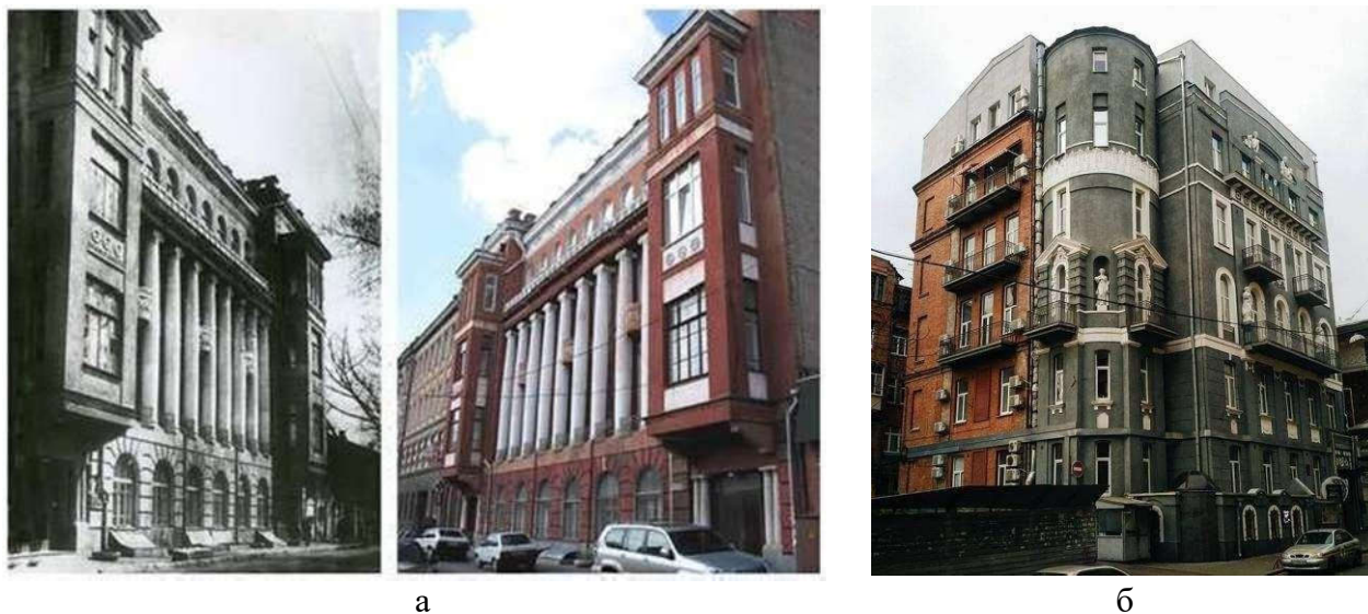
Рис. 4. Житлові будинки часів «старого міста»: а – пров. Плетнівський, 7; б – вул. Гоголя, 11
