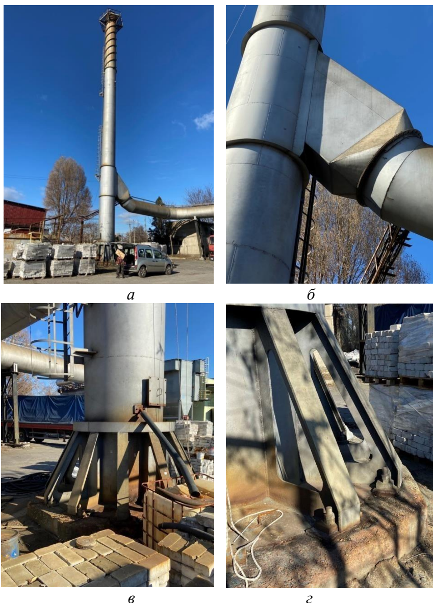
Рис. 1. Металева димова труба: а – загальний вигляд; б – врізання газоходу; г, д – кріплення до фундаменту
