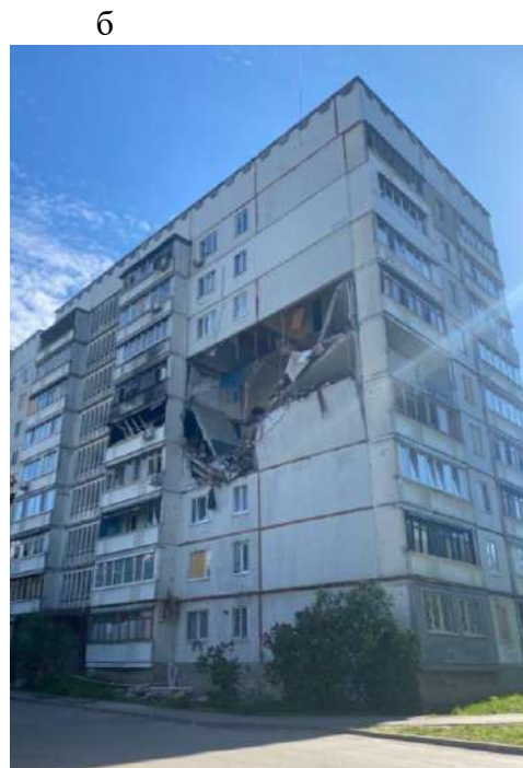
Рис. 1. Приклади руйнування панельної забудови міста Харків: а – обвалення несучих конструкцій будівлі від рівня покрівлі до фундаментів; б – руйнування несучих конструкцій 4-6 поверхів
