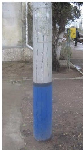
Рис. 3. Подовжні тріщини в опорах від корозії подовжньої арматури
