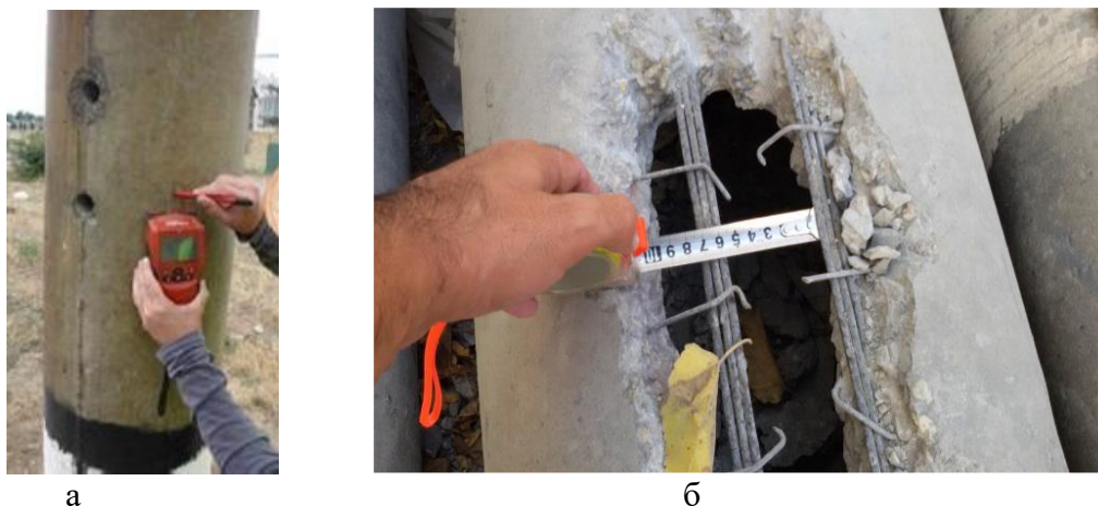
Рис. 1. Визначення товщини захисного шару бетону опор контактної мережі в польових умовах [13]: а – неруйнівним методом за допомогою приладу Hilti PS 50; б – прямими вимірюваннями в пробитих отворах
