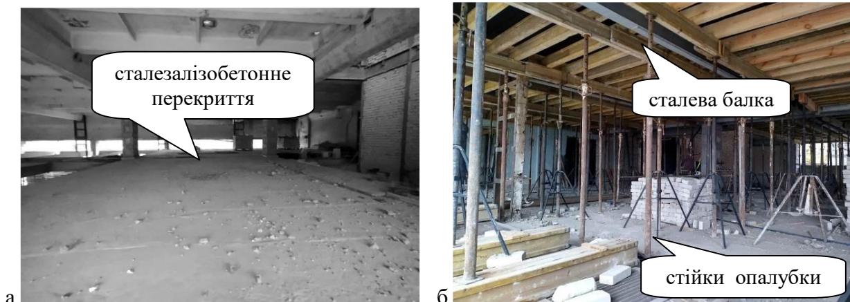
Рис. 3. Вигляд на СЗБ перекриття: а – зверху; б – знизу зі встановленою інвентарною опалубкою
