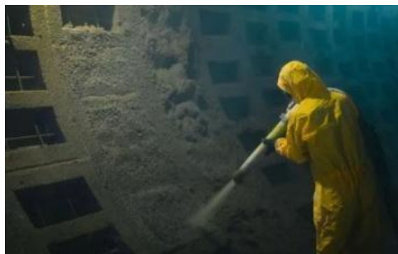
Рис 2. Торкретування тунелю установкою АС-1 Компанії «ТОРНАДО»
