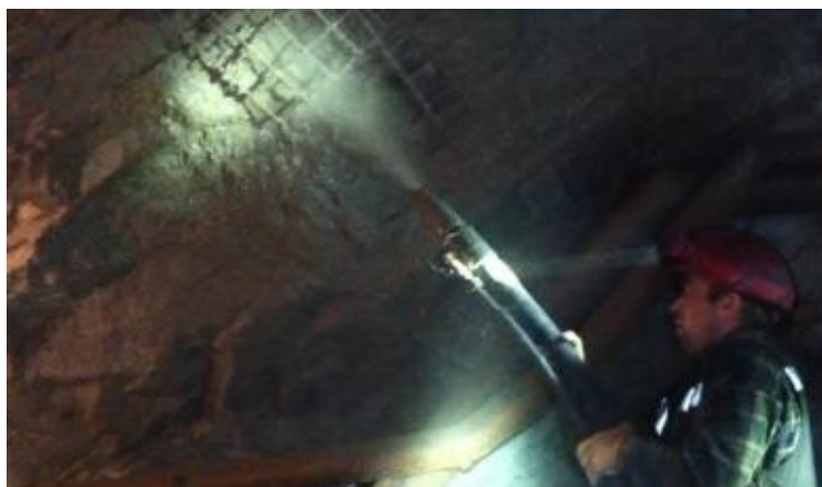
Рис. 4. Торкретування вертикальної поверхні шахтного ствола
