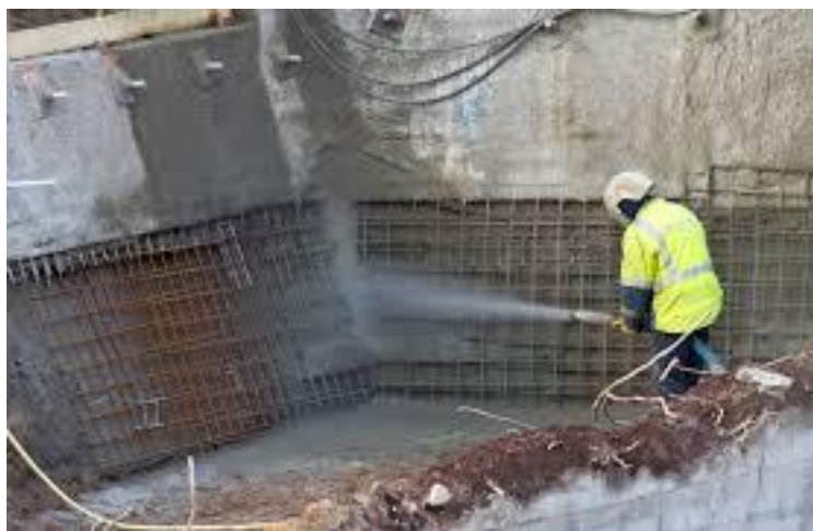
Рис. 3. Етапи підготовки поверхні для торкретування
