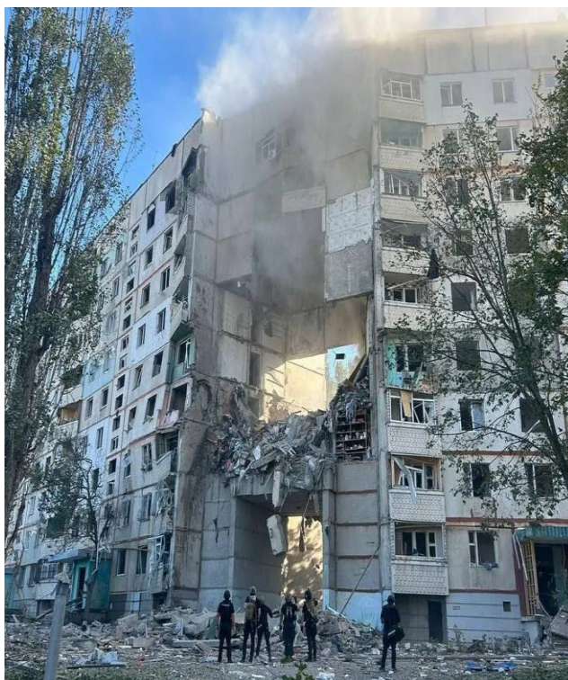
Рис. 1. Наслідки авіаційного удару по будівлі ВПБ за адресою м. Харків, вул. Метробудівників, 40 (24 вересня 2024 р.)
