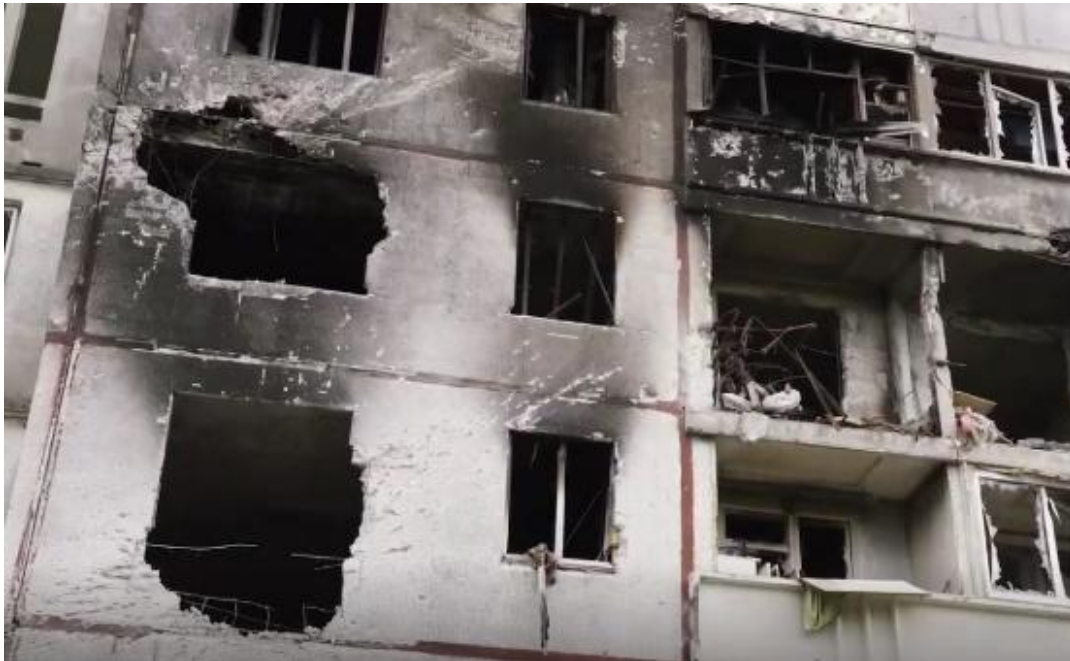
Рис. 1. Типові руйнування ВПБ
