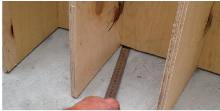
Рис. 12. Установлений проміжок між внутрішніми перегородками басейну та оболонкою
