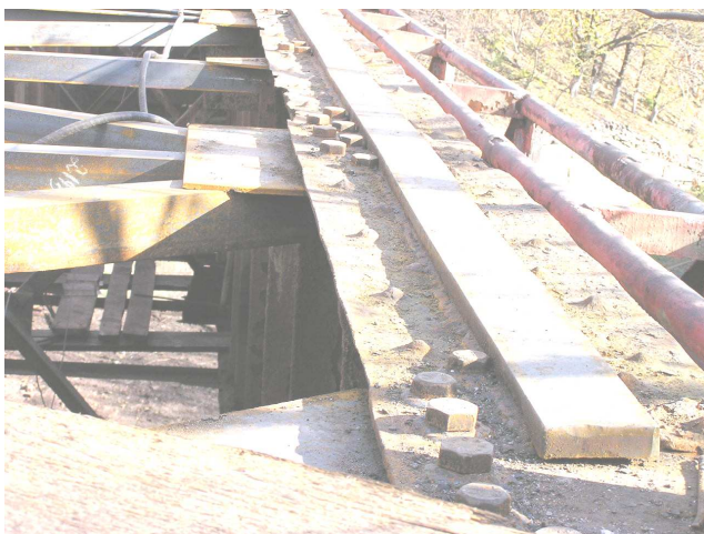
Рис. 5. Ремонтное восстановление верхнего строения пути
