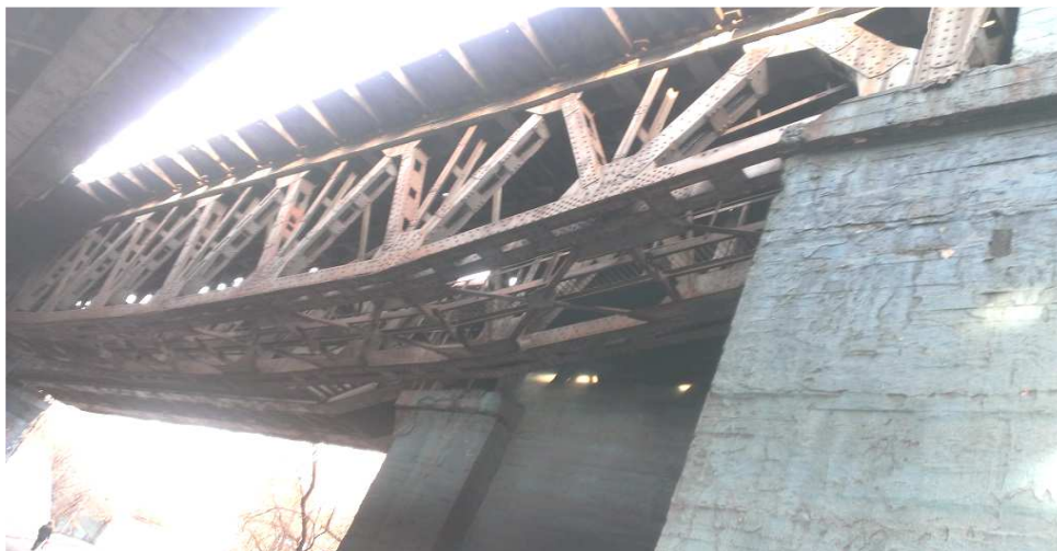
Рис. 4. Общий вид пролетного строения
