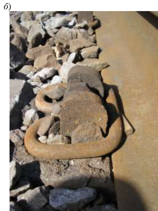
Рис. 5. Анкерне скріплення з високою поперечною жорсткістю АРС-4: a – деталь із з'єднаних скобою анкерів, зафіксована у формі перед формуванням шпал (Белгородський ЗЗБШ, Росія); б, в – характерні пошкодження – руйнування полімерних вкладишів на ділянці Іларионове – Синельникове Придніпровської залізниці
