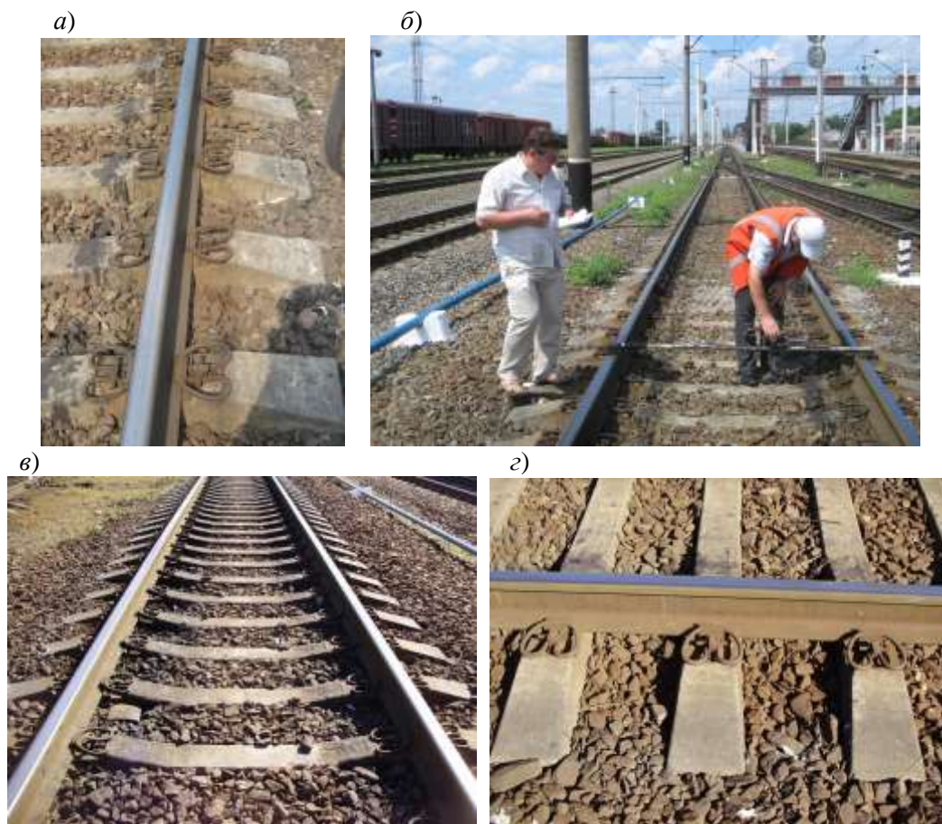
Рис. 10. Рейкові скріплення УС-1 в непарній колії 249 км ПК1 ділянки Основа – Букине Південної залізниці (між стрілочними переводами 550 і 572 станції Основа): а, б – через 9 років експлуатації (06.07.2011, ширина колії – 1518–1522 мм, перекид – не більше 2 мм); в, з – через 12 років експлуатації (05.10.2014, пропущений тоннаж – 259,3 млн. т брутто)
