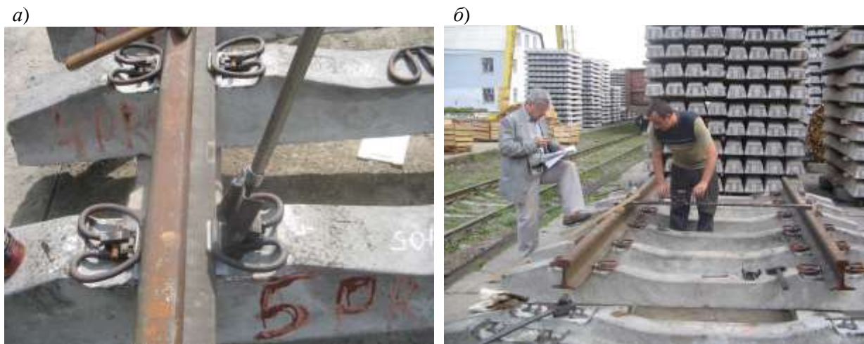
Рис. 12. Збирання ланки на шпалах Ш1-1-PRS: а – замикання скріплення ключем; б – контроль ширини колії – 1520 мм забезпечено
