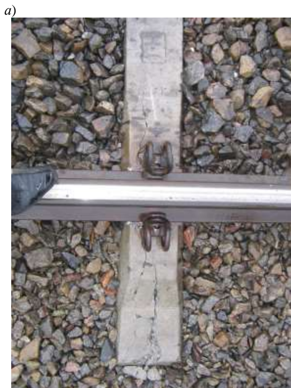
Рис. 4. Характерні пошкодження залізобетонних шпал зі скріпленнями з високою поперечною жорсткістю – подовжні тріщини від анкера до торця шпали: а, б – шпали СБ3-1 зі скріпленням КПП-5; в – шпали зі скріпленням Vossloh W 14 (Литовська залізниця)
