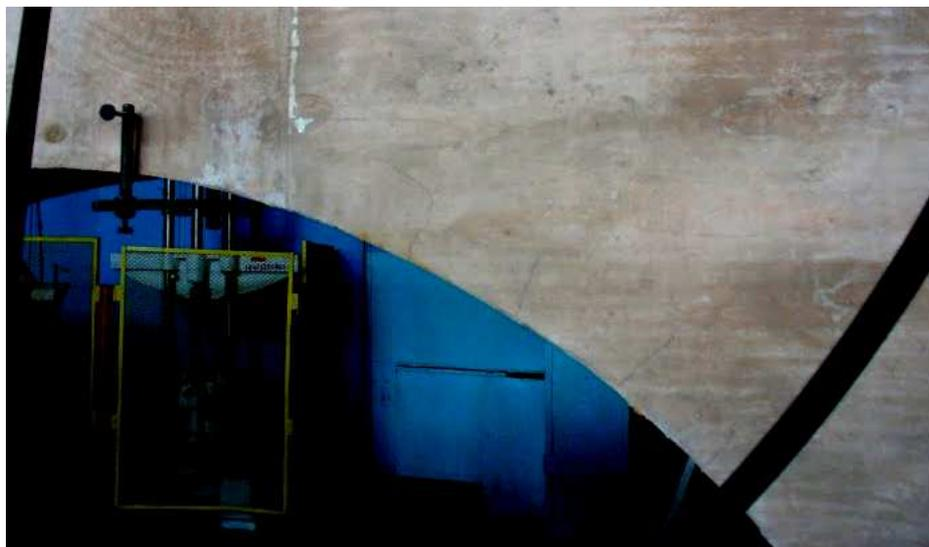
Рис. 10. Появление трещин на нижнем контуре арочного свода бора
