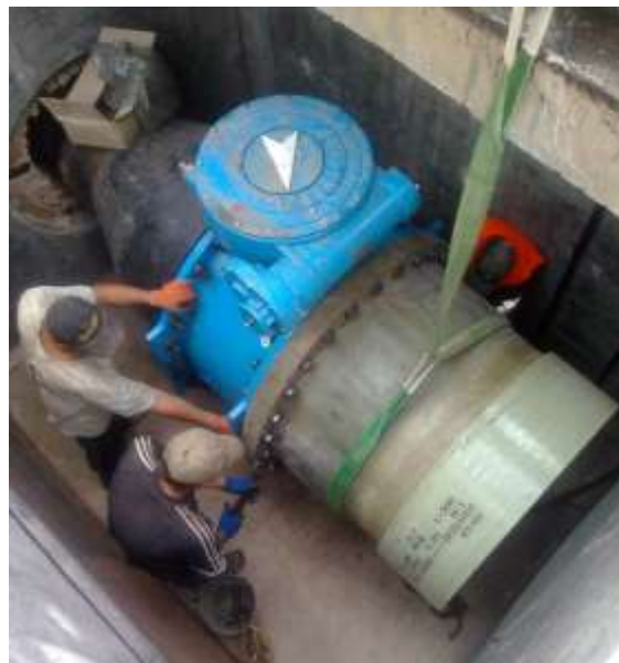
Рис. 7. Фланцевое соединение водовода из стеклопластика диаметром D_y=1000 мм по ул. Ахсарова в Харькове
