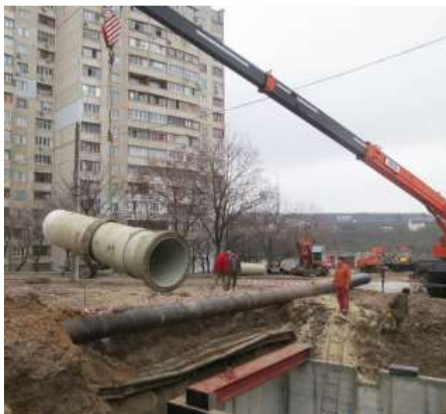
Рис. 2. Монтаж стеклопластиковой трубы
