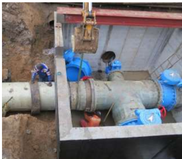
Рис. 5. Раструбное соединение стеклопластиковых труб в камере
