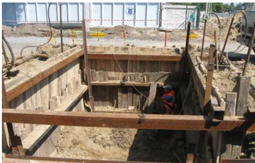
Рис. 1. Устройство крепи и системы иглофильтров вакуумного водопонижения на одном из участков сети водоотведения Харькова
