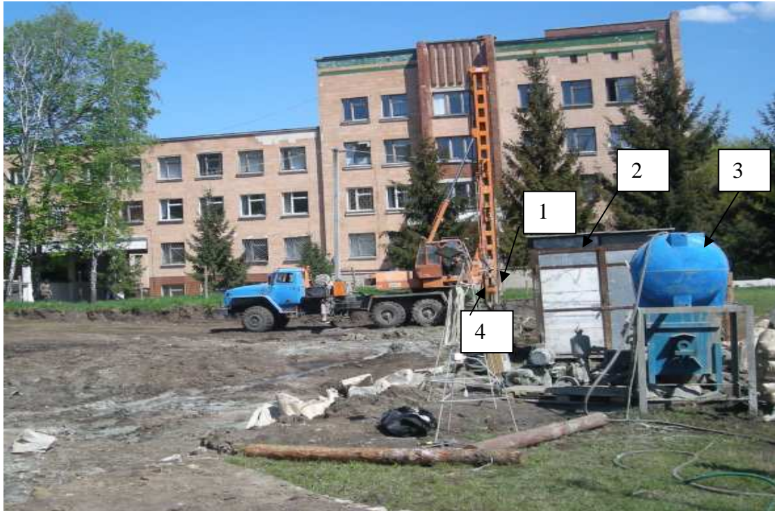
Рис. 5 Загальний вигляд комплекту обладнання для виготовлення ґрунтоцементних елементів за бурозмішувальною технологією: 1 – буровий верстат; 2 – схованка для розчиномішалки, розчинонаосу, склад цементу; 3 – ємність для води; 4 – напірний шланг
