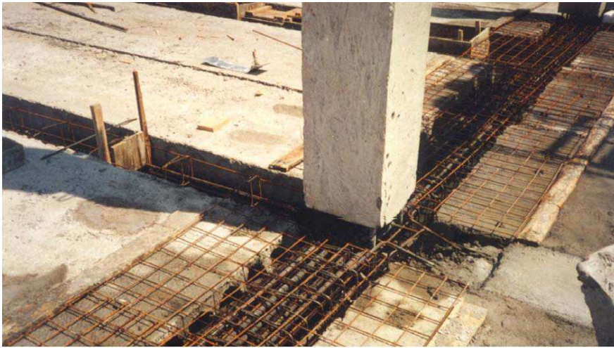
Рис. 3. Сполучення плит і ригелів перекриття системи «АРКОС»
