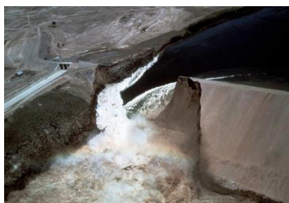
Руйнування греблі внаслідок прориву
